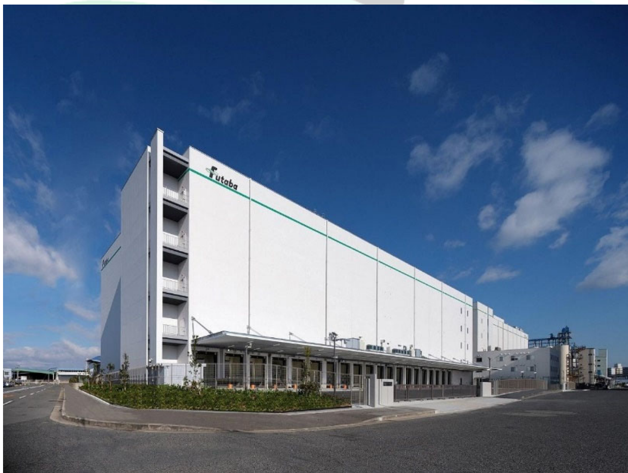
〔手前側が2期棟〕
